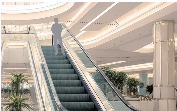
商業施設の吹き抜け折り上げ間接照明は、エスカレーターからの視線に注意
