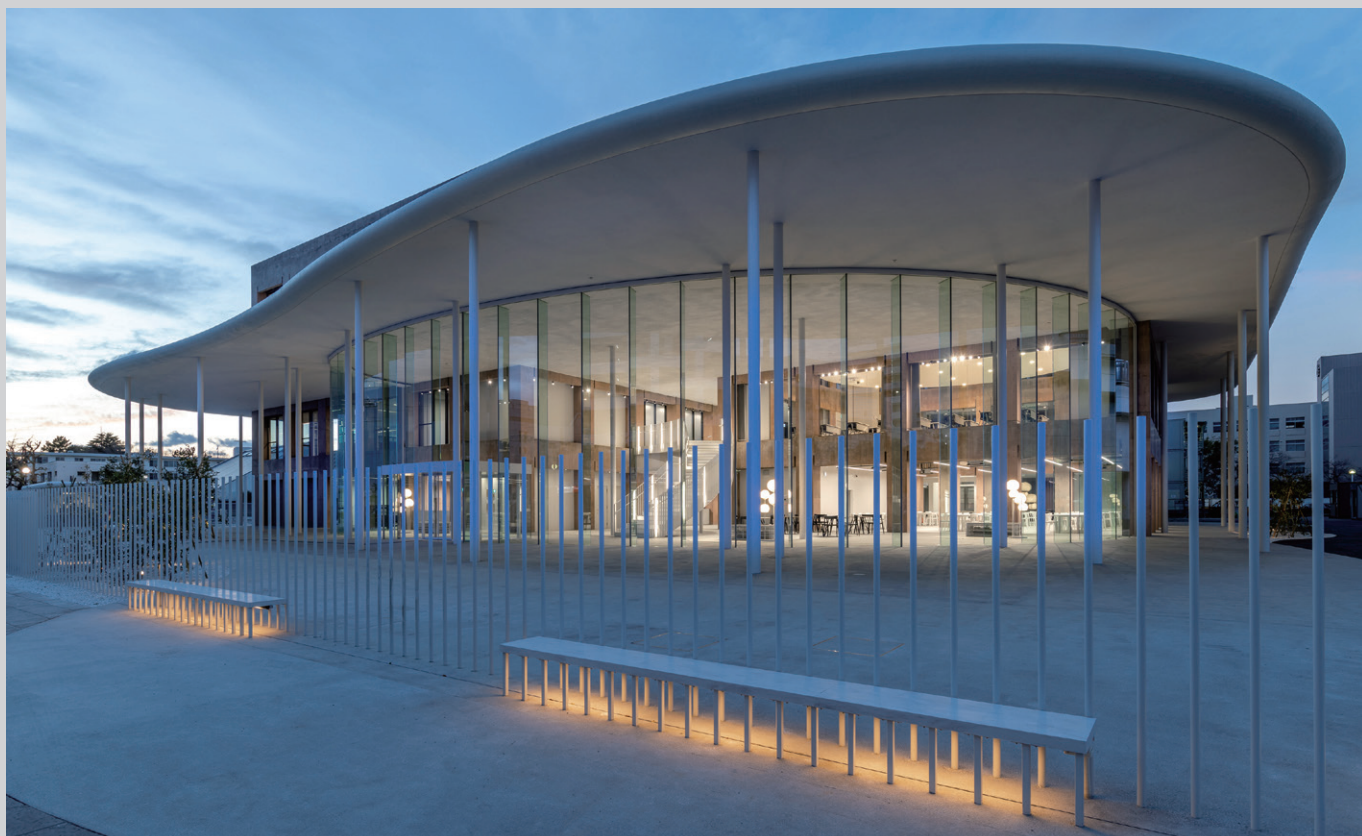
神奈川歯科大学キャンパスセンター 所在地：神奈川県 設計：アトリエ MEME 照明設計：大光電機株式会社 施工：五洋建設株式会社 写真：ブルーアワーズ／沖 裕之
